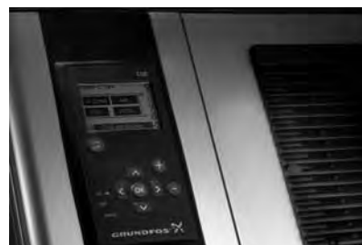
Fig. 26 Interface utilisateur Grundfos CUE
